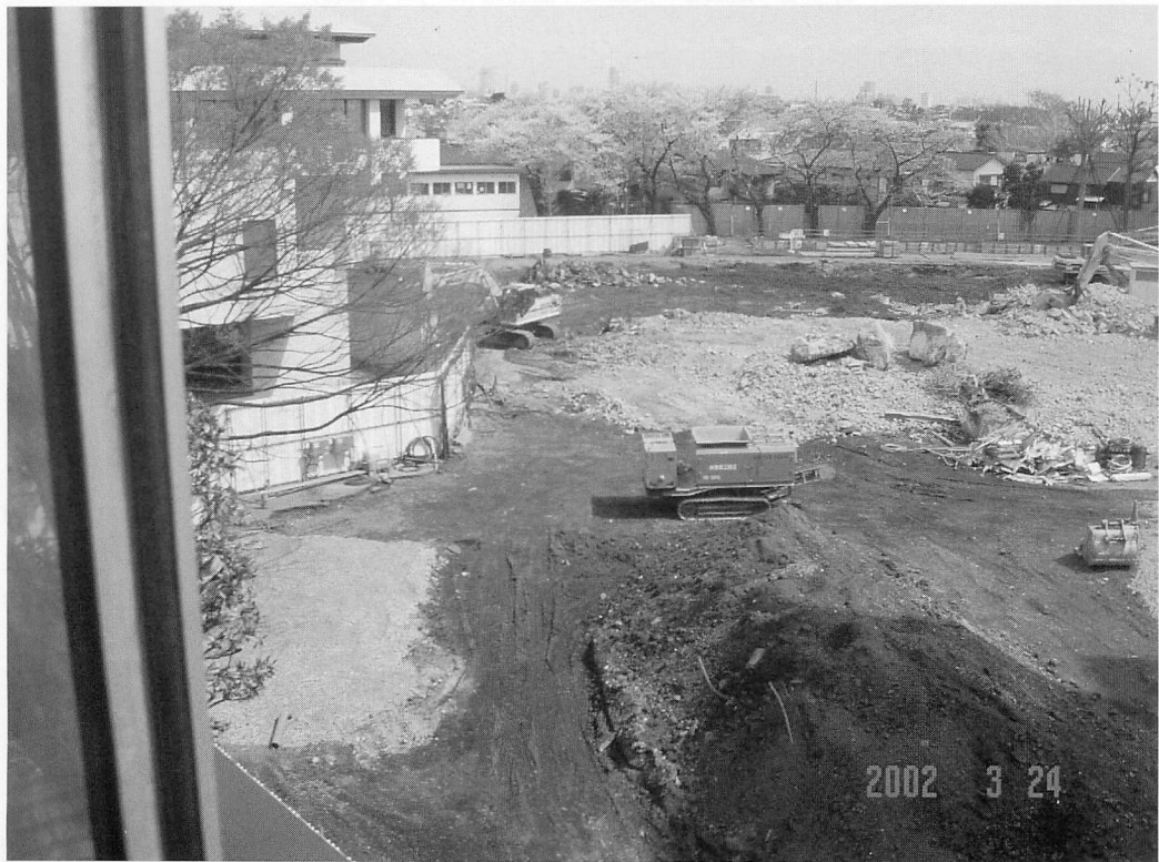
工事の進む第1体育館と大講堂の解体作業。跡地には図書館が建設される。
